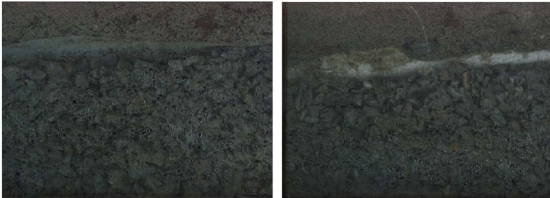
Figur 9. Bilder från skanner i växtbäddar av skelettjord, Stockholmmodellen, med Lind ( Tilia cordata ) planterade. Blekingegatan, Stockholm, 7 augusti 2016. Bilden till vänster är tagen vid ett restaurerat träd (träd nummer 3) och den högra bilden från ett nyplanterat träd (träd nummer 8). På bilderna ser vi sättsand, geotextil och det luftiga bärlagret.
