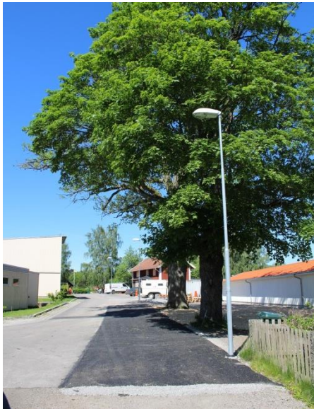
Figur 7. Tv. vägkroppen till höger närmast träden är uppbyggd enligt principen för dränasfalt (foto: VIÖS AB). T.h. principskiss uppbyggnad för dränasfalt (Svenskt vattens publikationsserie P105).
