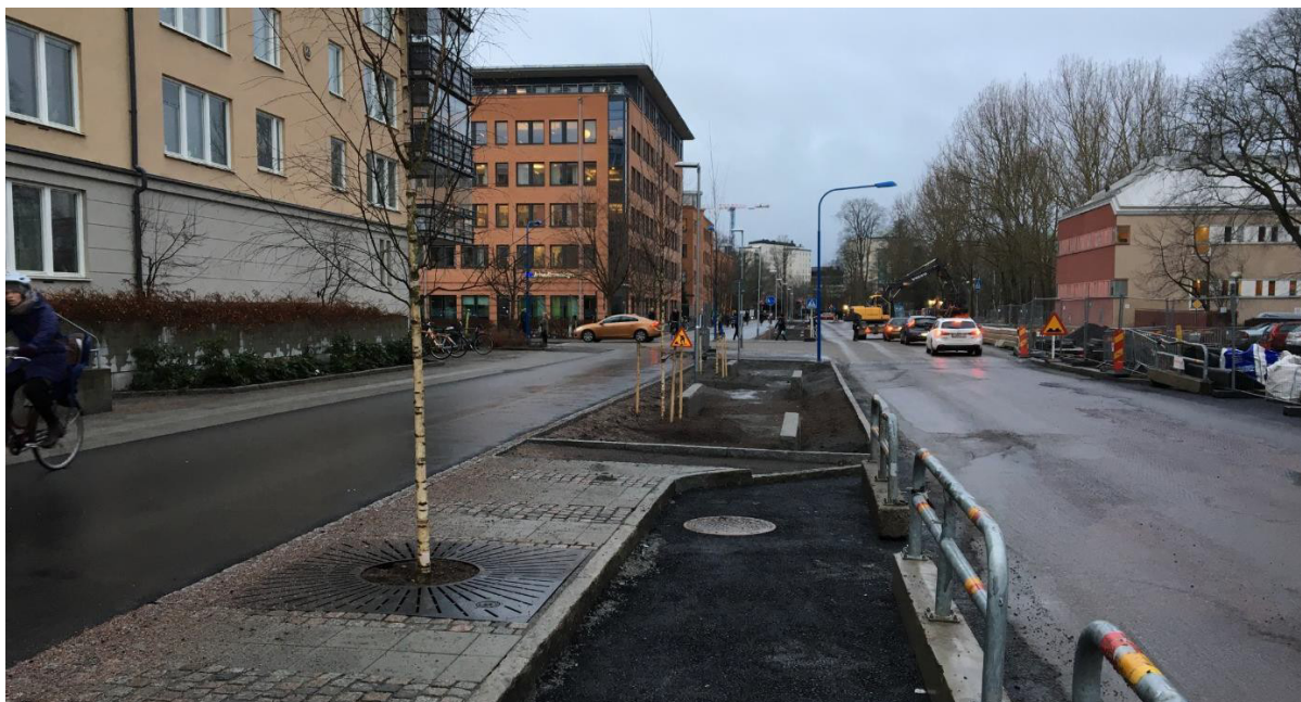
Figur 30. Grönblå systemet på Strandbogatan i Uppsala med luftigt förstärkningslager, regnbädd och trädgrop. (Foto: Kent Fridell)
