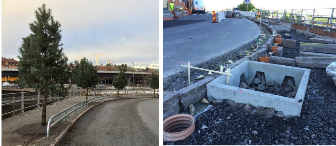
Figur 15. Konstruktion av växtbädd med kolmackadam på Rörstrandsgatan i Stockholm. (Foto: Björn Embrén???)
