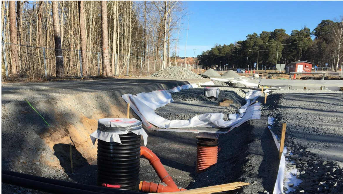
Figur 28. Grönblått gaturum med regnbädd under byggnation i Rosendal. Styrningsbrunn i förgrunden i schaktet för det blivande luftiga förstärkningslagret. (Foto: Kent Fridell)
